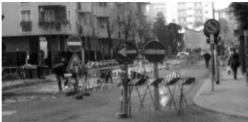
I lavori in via Resistenza
