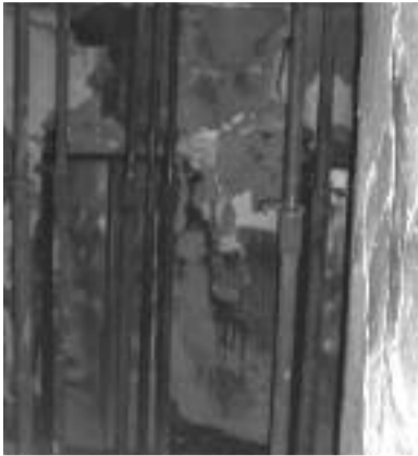
Tubi innocenti per sostenere il plafone
